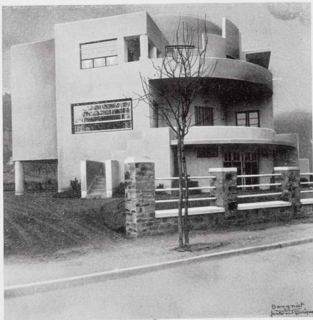
VILLA AU BORD DE LA MEUSE. Architectes : Leborgne Frères. Troisième mention.
